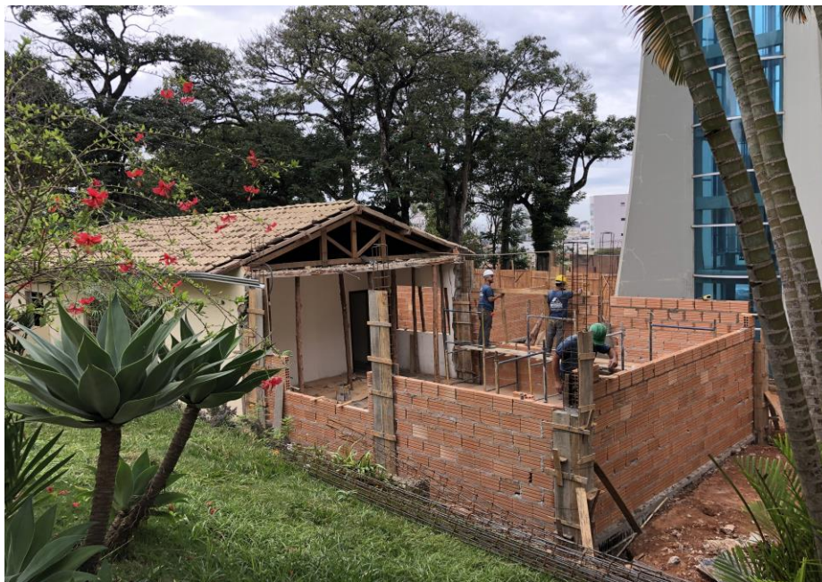
Figura 6 - Acompanhamento da reforma do prédio da procuradoria em Varginha - Minas Gerais. Foto tirada no dia 02/05/2019.
