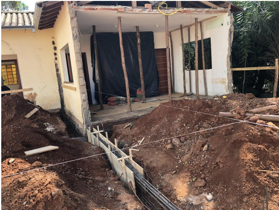
Figura 5 - Acompanhamento da reforma do prédio da procuradoria em Varginha – Minas Gerais. Foto tirada no dia 12/04/2019.
