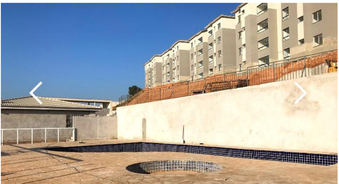
Figura 2: Portal Recanto das Pétalas - Varginha/MG.
