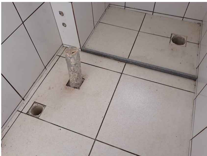
Figura 22: Revestimento cerâmico interno no chão do banheiro.
