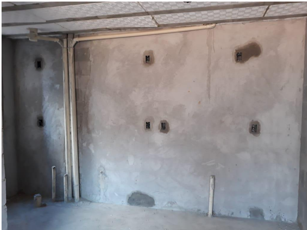
Figura 11: Revestimento interno em argamassa na cozinha - Emboço.
