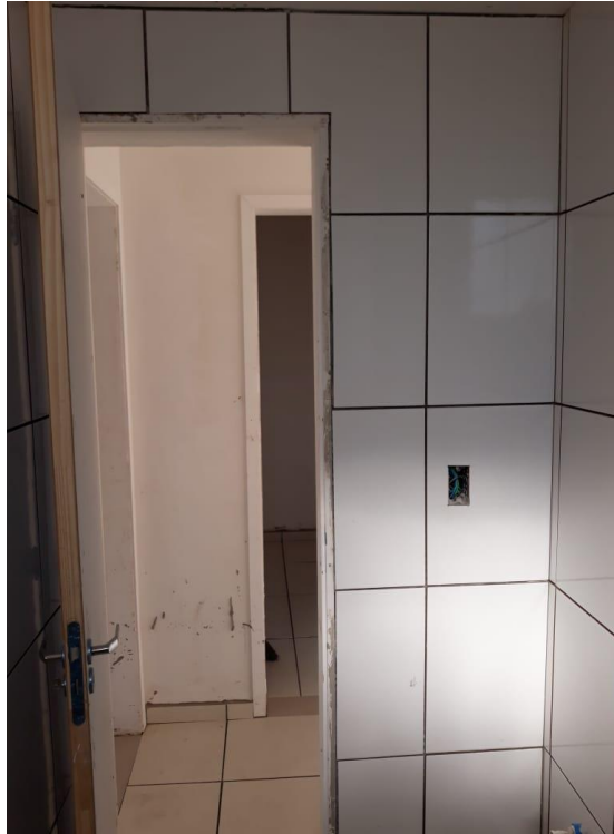
Figura 20: Revestimento cerâmico interno nas paredes do banheiro.
