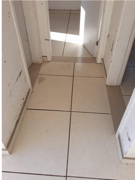
Figura 23: Revestimento cerâmico interno no chão do corredor.
