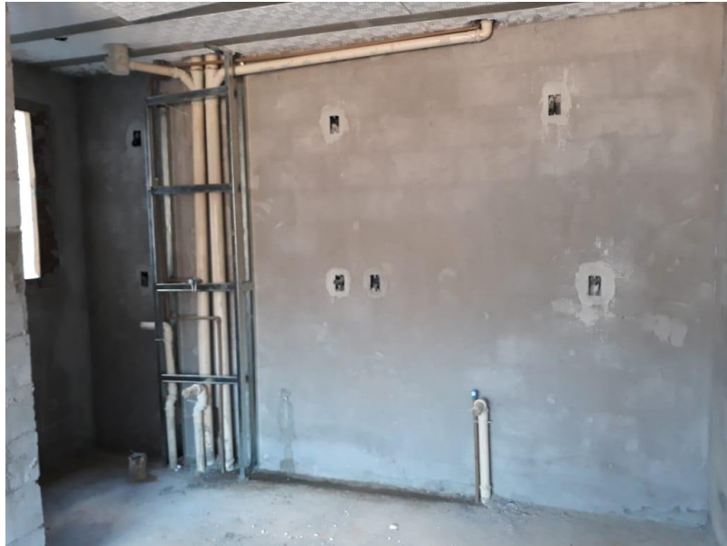
Figura 12: Revestimento interno em argamassa e estrutura do shaft na cozinha.
