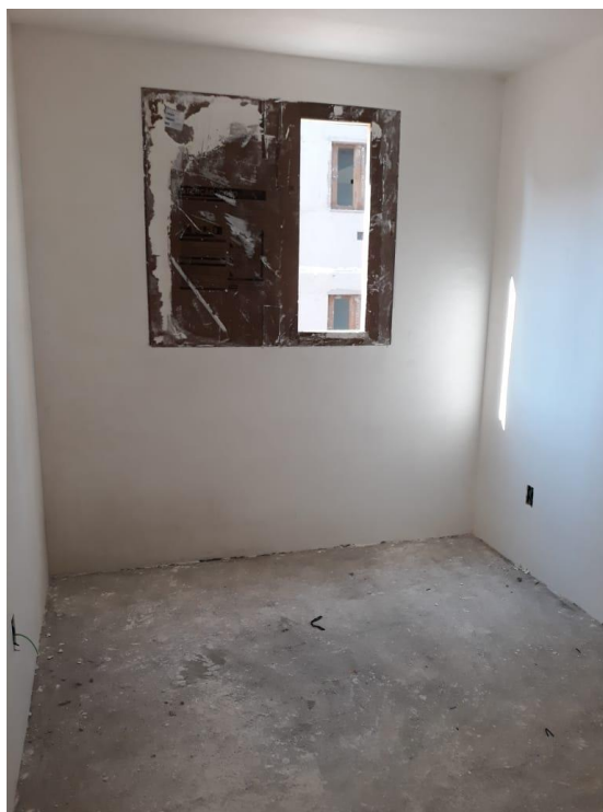
Figura 16: Revestimento interno em gesso liso no quarto de solteiro.
