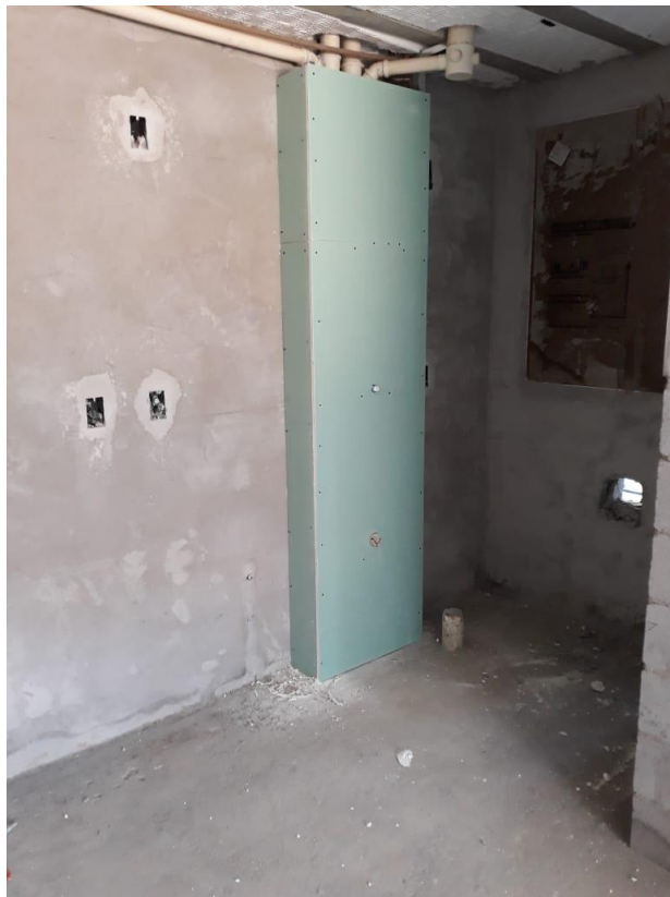
Figura 13: Revestimento interno em argamassa e shaft de placas de drywall.
