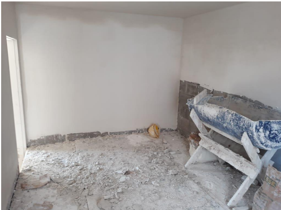
Figura 18: Execução de gesso liso, iniciado no teto e depois nas paredes.
