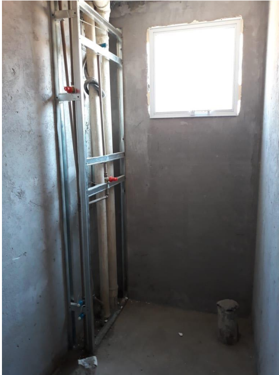
Figura 14: Revestimento interno em argamassa no banheiro e estrutura shaft.
