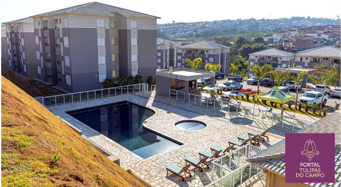
Fonte: BRZ Empreendimentos e Construções (2019).
