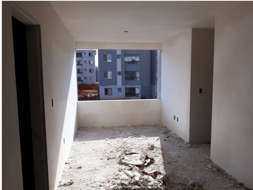
Figura 15: Revestimento interno em gesso liso.
