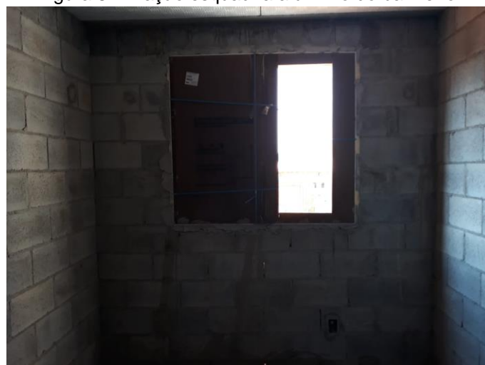
Figura 8: Fixação esquadria alumínio do banheiro.
