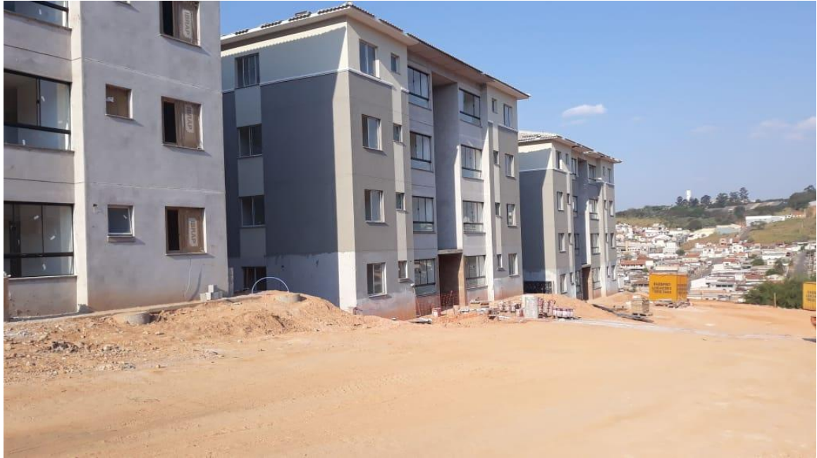
Figura 6: Empreendimento em andamento com 75% dos blocos finalizados.
