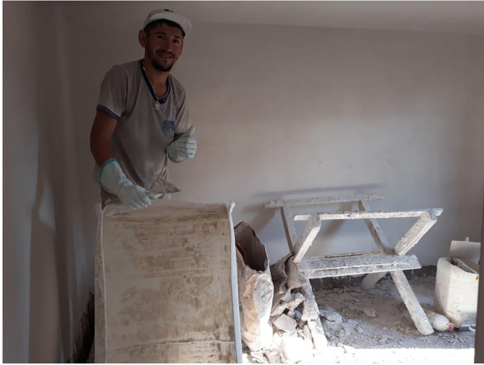
Figura 17: Gesseiro após executar revestimento de gesso liso nos tetos/paredes.
