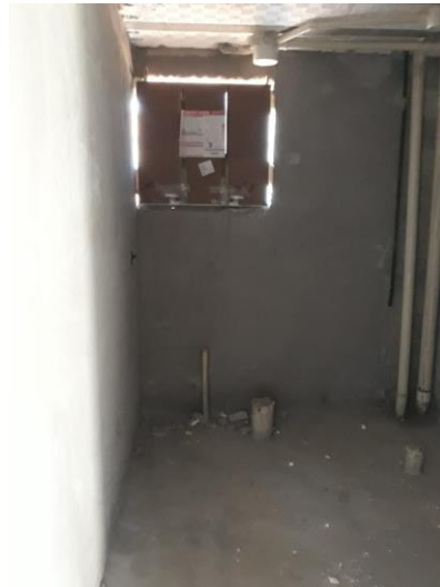
Figura 7: Fixação esquadria alumínio do banheiro.
