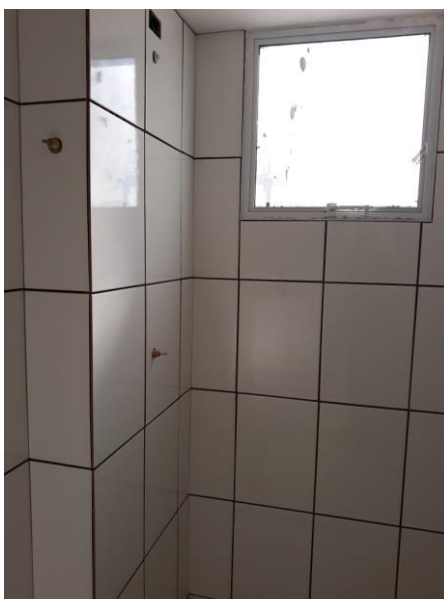
Figura 19: Revestimento cerâmico interno nas paredes do banheiro.
