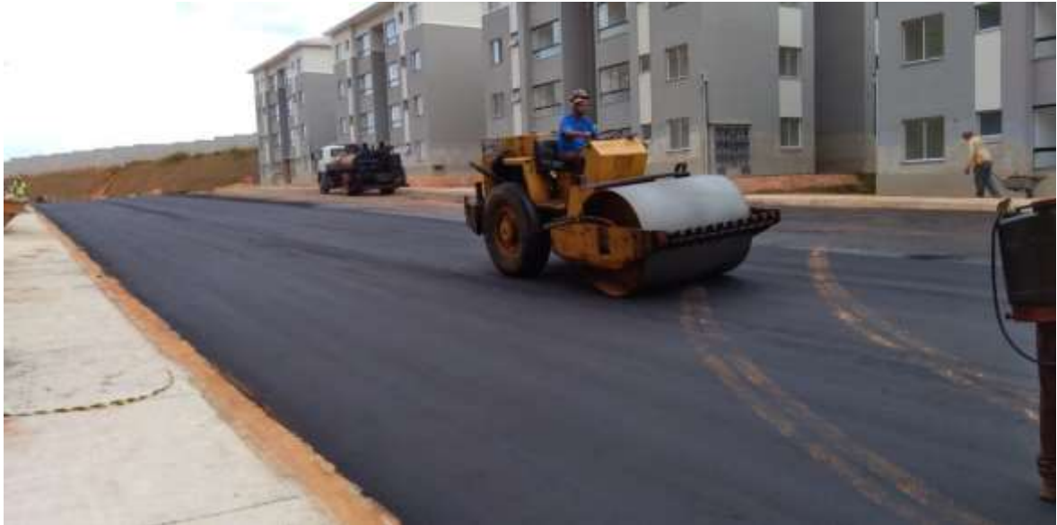
Figura 16: Compactação do asfalto.
