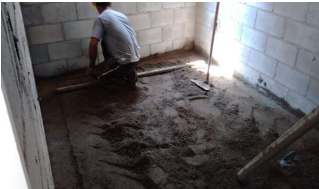
Figura 4: Processo de regularização da camada de contrapiso.
