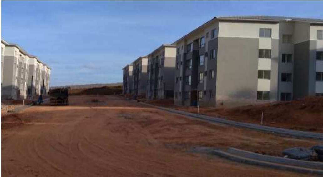
Figura 13: Execução do meio fio.
