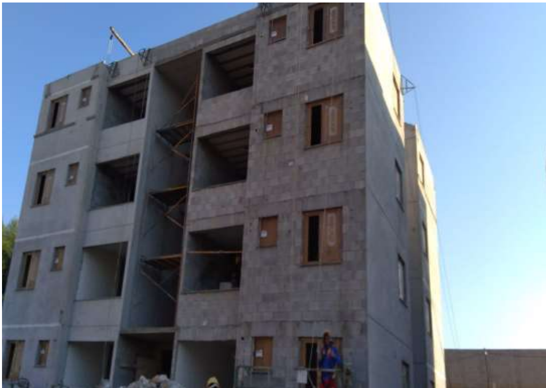
Figura 7: Reboco sendo realizado na fachada do edifício.
