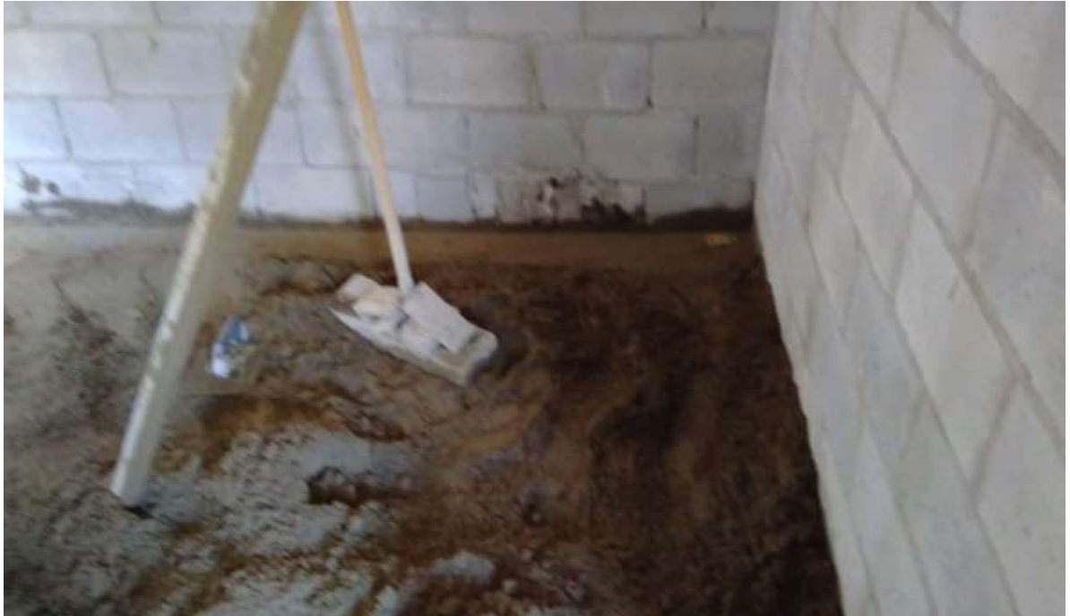
Figura 3: Fase de execução do contrapiso, dentro dos apartamentos.
