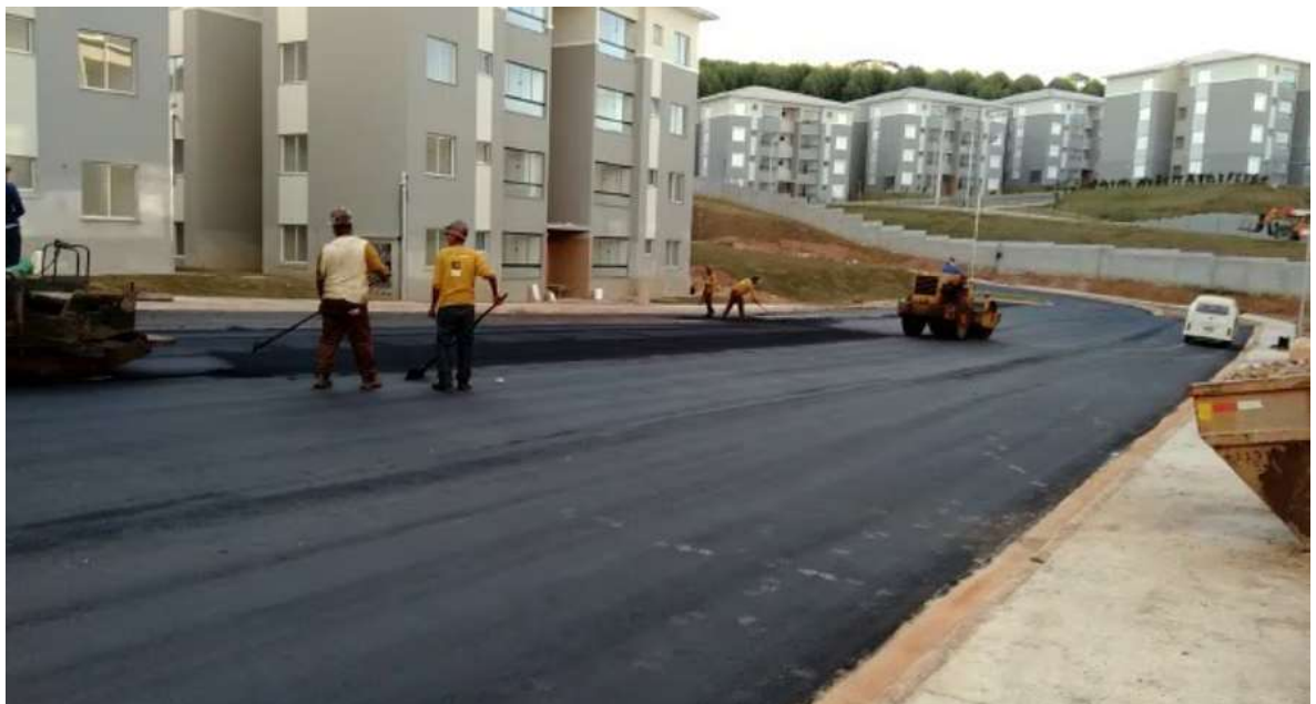
Figura 16: Execução da Pavimentação.
