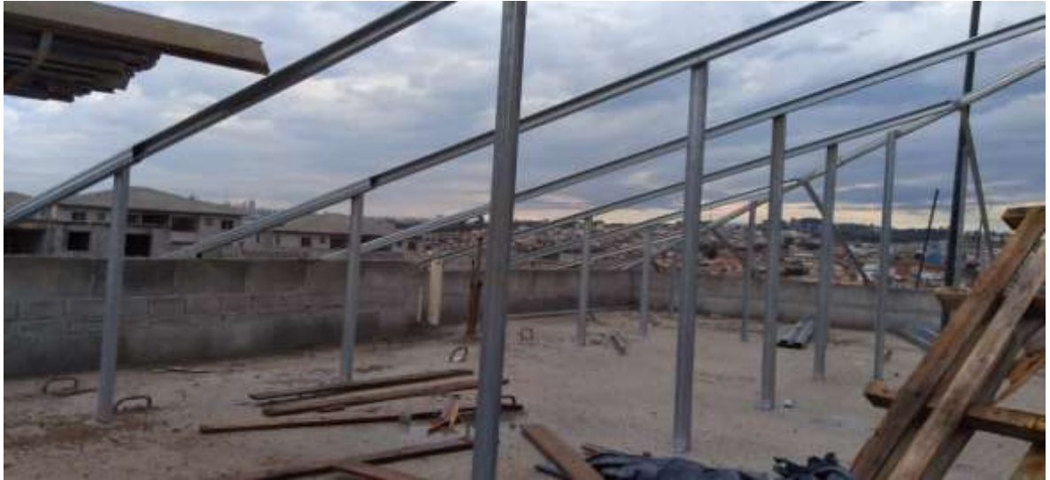
Figura 10: Execução do telhado em estrutura metálica.
