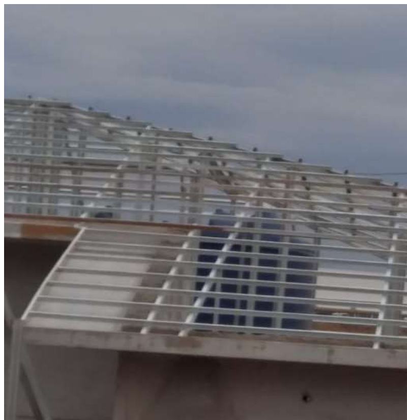
Figura 11: Execução do telhado em estrutura metálica.
