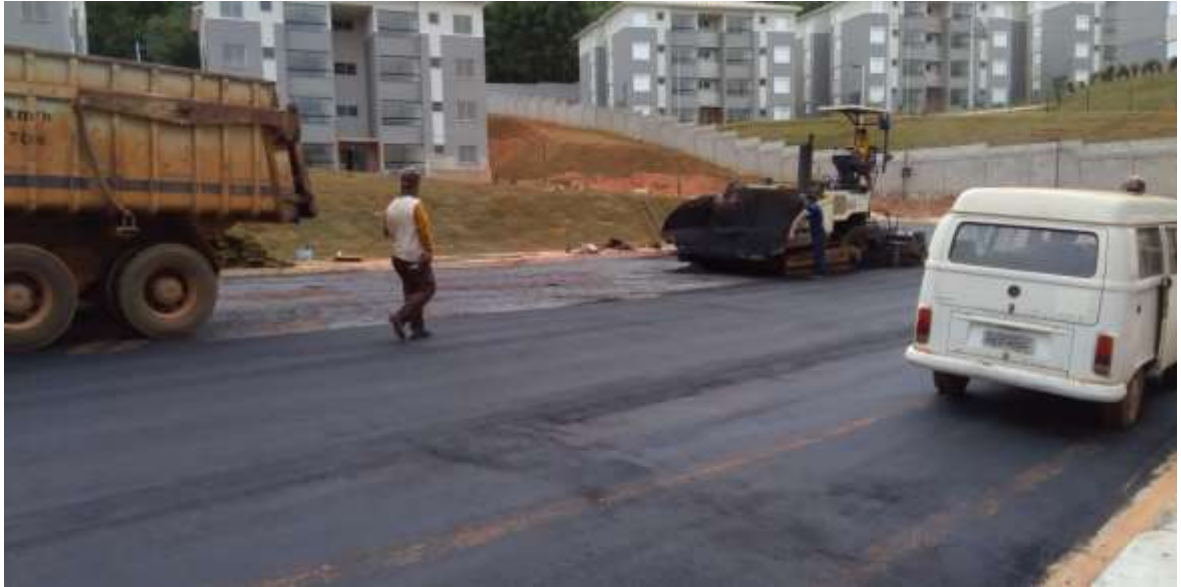
Figura 15: Execução da pavimentação.
