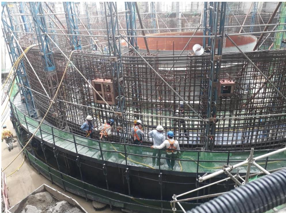
**Figura 5 Concretagem parede do gerador com forma deslizante.**
