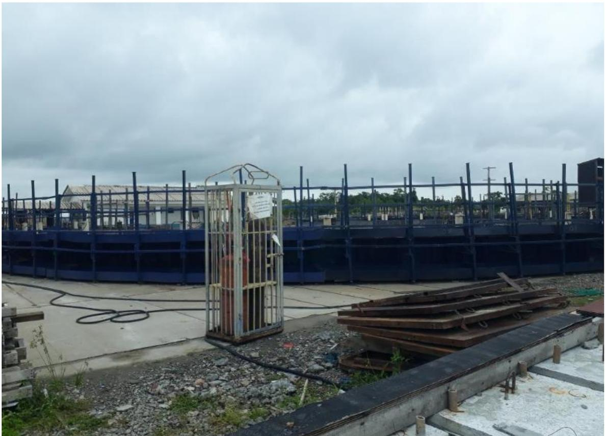
**Figura 6** Forma deslizante utilizada na obra.
