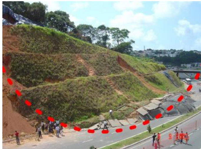
Figura 11 – Diferentes superfícies de ruptura: (a) Escorregamento planar; (b) Escorregamento rotacional.
