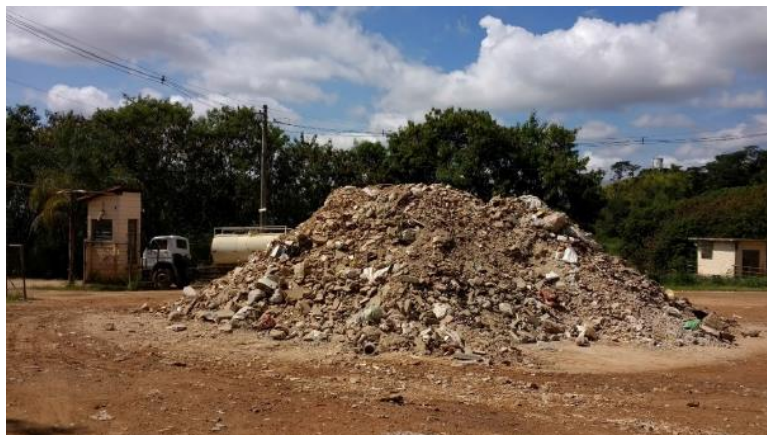
Figura 6: Área de transbordo e triagem de entulhos.
