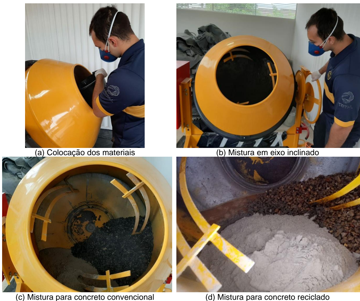
Figura 35: Dosagem dos concretos em betoneira de eixo inclinado com capacidade de 400L.
