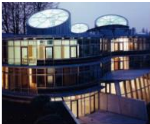
(a) Prédio Administrativo da Fundação Federal Alemã para o Meio Ambiente (DBU)
